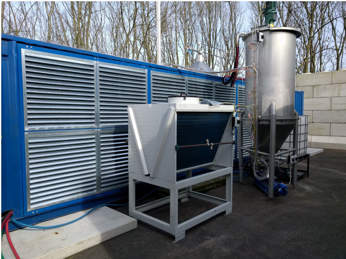
FIGUUR 2.4 DE INSTALLATIE MET EFFLUENT-NAKOELER EN SLIBSILO BIJ DE START VAN HET PROJECT. GEDURENDE HET PROJECT IS DE INSTALLATIE OP VERSCHILLENDE ASPECTEN AANGEPAST
